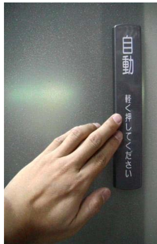
圖 18 壓電材料，經手給予壓力後造成材料導電性提高，使得門能自動開啟
